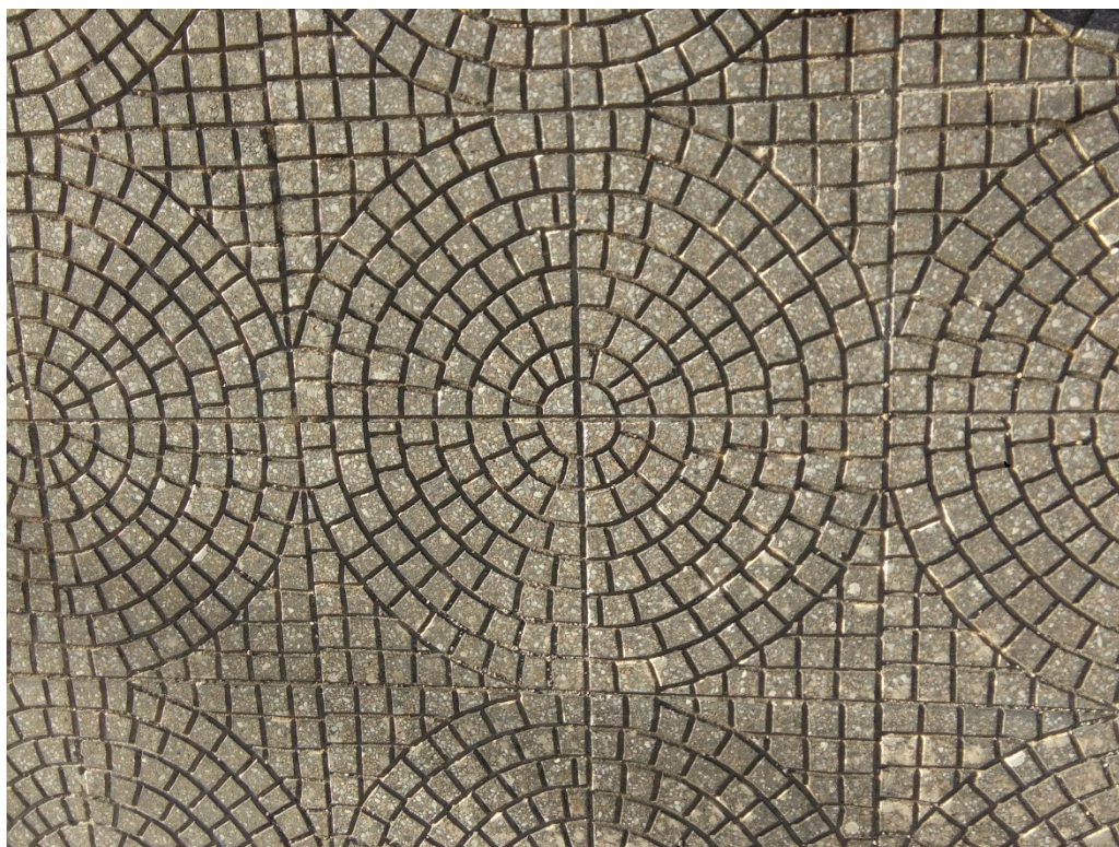
Tipologia della pavimentazione
